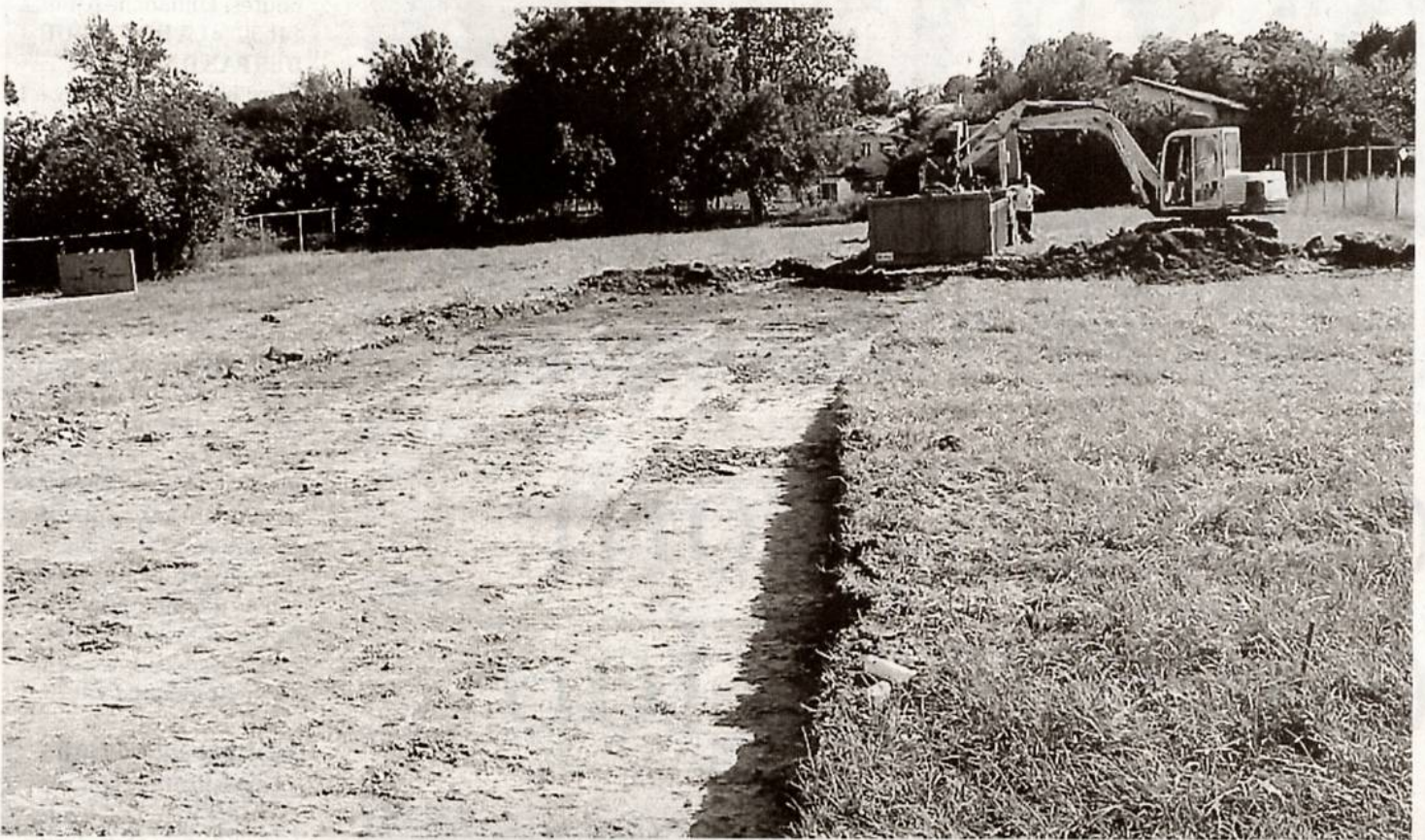
Début des travaux avec des terrassements à la nouvelle gendarmerie. / Photo DDM, Pierre Mauron
